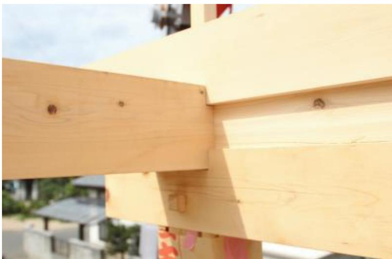
今回の試みとして、通常、各階の柱は3mの長さを使うのですが、今回は4mの柱を使って1階と2階を通して使っています。2階は通常なら平屋建ての小屋裏扱いとなる部分ですが、下の写真のように組むことにより居住空間が作れます。このことによって、コストを大幅に下げることが可能となります。
